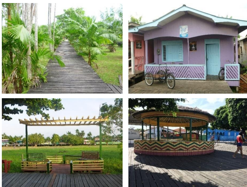
Figura 37 - Construções em madeira. Acervo: autora, 2016.
