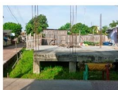
CONSTRUÇÃO EM CONCRETO ARMADO
