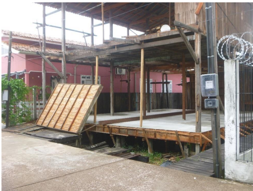
Figura 35 - Construção em andamento com o sistema híbrido esteio de madeira e piso em concreto. Acervo: autora, 2016.
