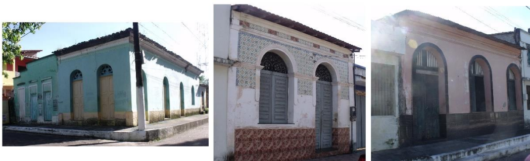
Figura 03: Algumas construções antigas de Marapanim localizadas próximo ao Paço Municipal Monsenhor Edmundo Igreja.
