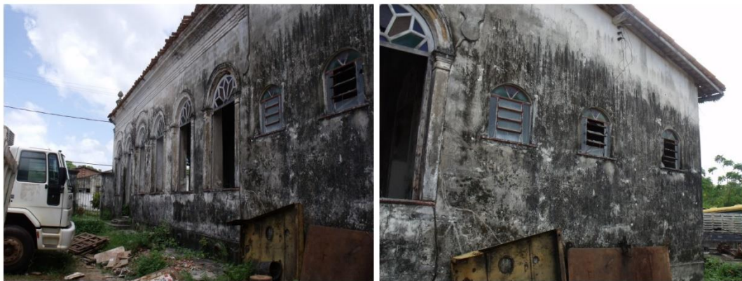
Figura 13: Esquerda: Vista diagonal do PG4 na área que ainda conserva uma leitura do antigo. Direita: Novos balancins instalados na área molhada inserida na edificação.
