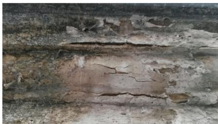
Polito (2006) aponta como possíveis causas de fissuras a aplicação de tinta em uma camada muito espessa, geralmente, sobre superfície porosa; a aplicação de tinta em camada muito espessa a fim de melhorar o poder de cobertura de um produto de baixa qualidade; o acúmulo de tinta nos cantos da superfície durante a aplicação; e a fragilidade do material já envelhecido com perda de propriedades.
