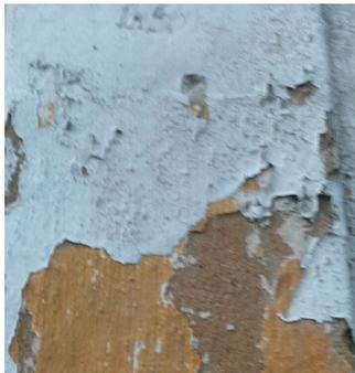
O uso de tintas de baixa qualidade, que ofereçam pouca adesão e flexibilidade, a exagerada diluição da tinta, a inadequada preparação da superfície, a aplicação de tinta sobre madeira bruta sem selador, a fragilização da tinta por envelhecimento, ou a incompatibilidade de materiais são possíveis causas deste dano (POLITO, 2006).
