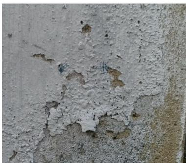
As possíveis causas para este dano são: a aplicação de tinta à óleo ou alquídica sobre superfície úmida ou molhada; umidade por infiltração ou capilaridade através das paredes (menos provável com tintas à base de água); superfície pintada exposta à umidade, logo após a secagem, principalmente se houve inadequada preparação da superfície (POLITO, 2006).
