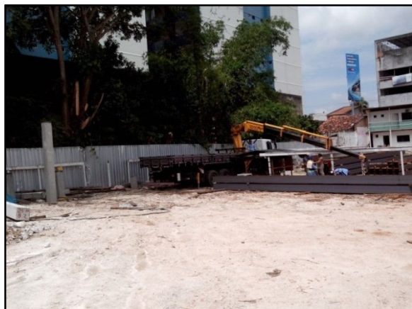
Foto 13 – Vista interna do canteiro de obras 03
