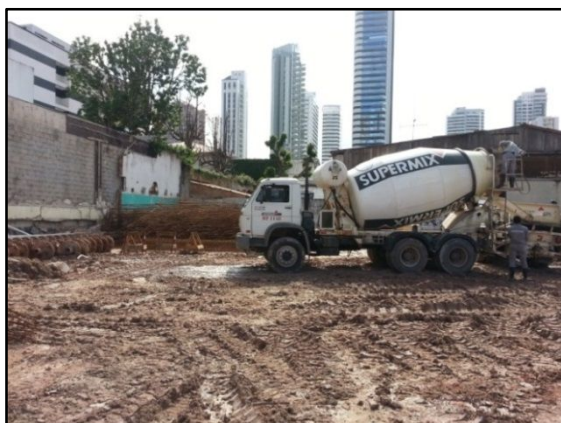
Foto 3 – Execução de obra de fundação
