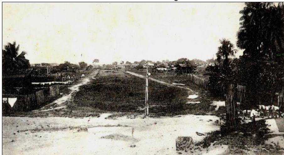
Foto 20 – Início das obras de macrodrenagem da Bacia das Armas
