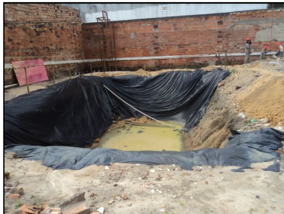
Foto 8 – Obras iniciadas com movimentação de terra
