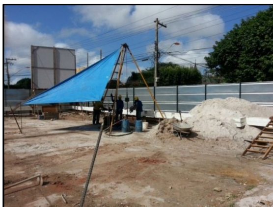
Foto 4 – Vista interna do canteiro de obras 01
