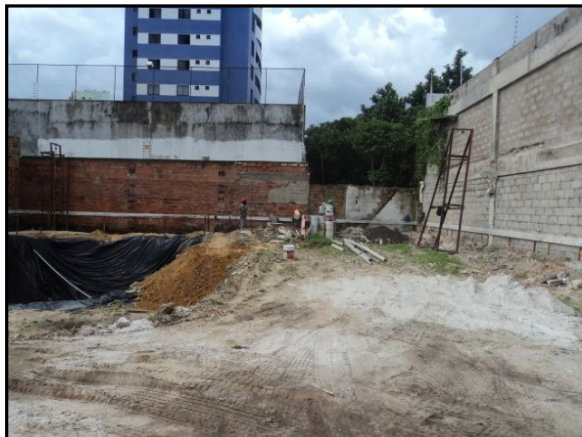
Foto 7 – Vista interna do canteiro de obras 02
