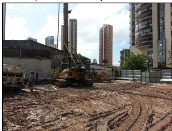
Foto 2 – Vista geral da instalação da obra, quando da solicitação de LI
