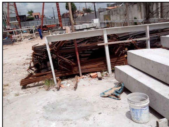
Foto 14 – Armazenamento de ferragem
