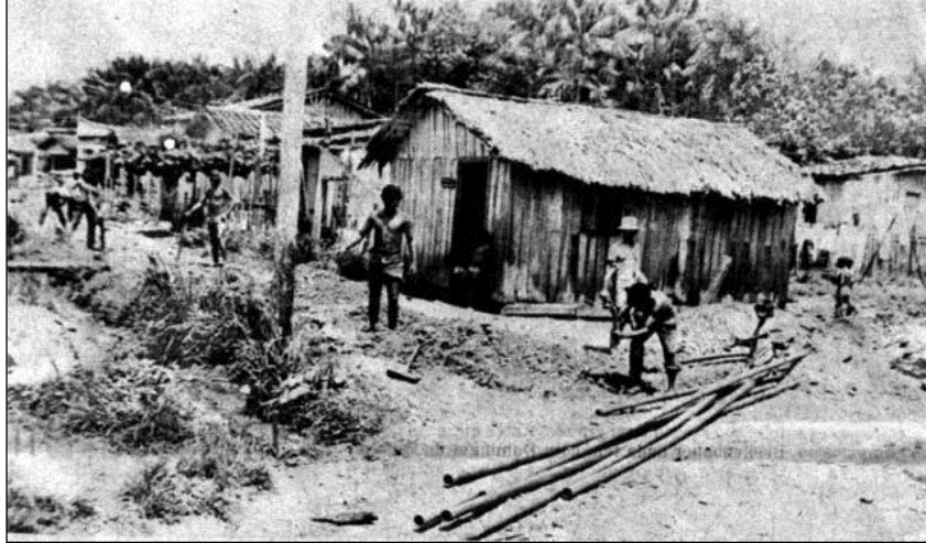
Foto 19 – Perfil de ocupação da área da Bacia das Armas antes das obras de macrodrenagem
