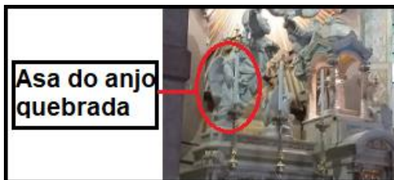
Figura 68: Asa do anjo do Altar Mor danificada
