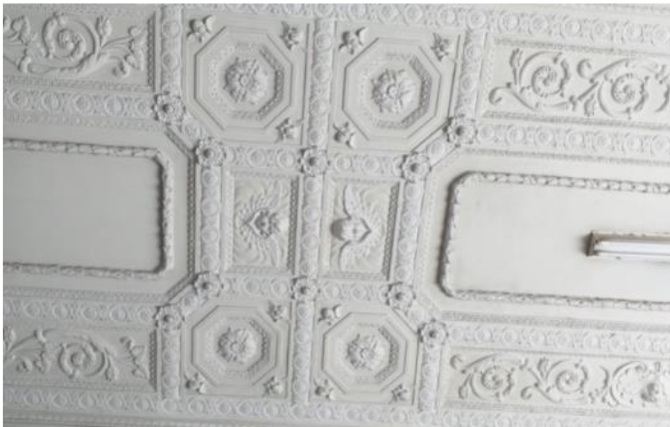
Figura 42: Forro do Corredor da Basílica
