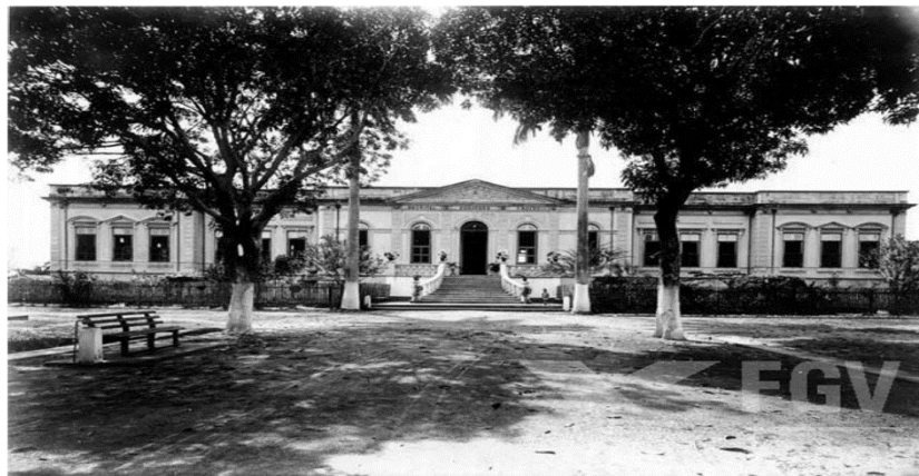
Figura 24: Hospital de Isolamento Domingos Freire
