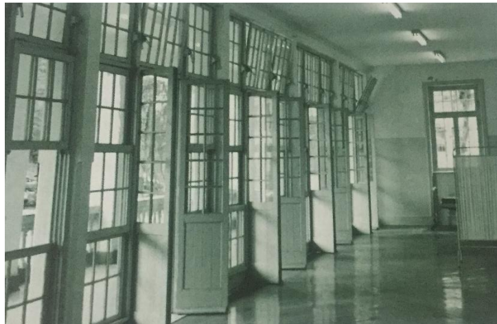
Figura 23: Esquadrias articuláveis do Sanatório Vicentina Aranha usadas para o fechamento das enfermarias.
